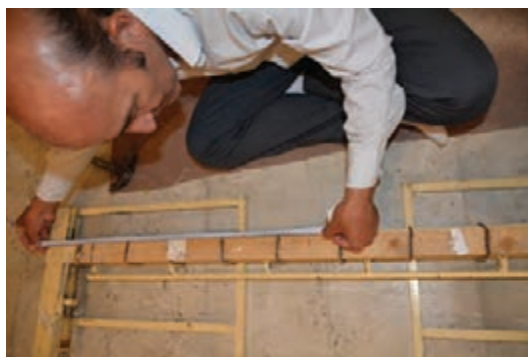
شکل ۱۸-۵ - نشانه گذاری بر روی چوب پایین کشی
