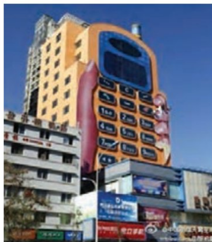
شکل ۱۱۰-۳- تصویر چاپ بر روی ساختمان
