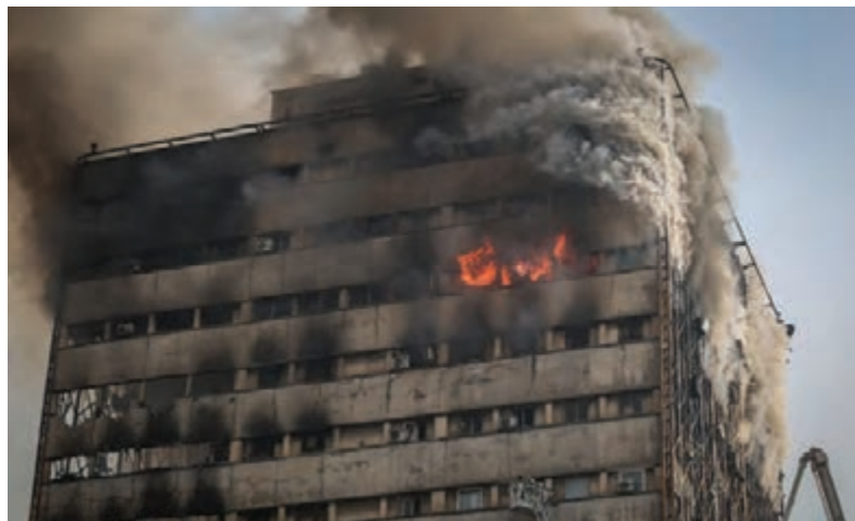
تصویر ۲۶- پخش زنده تصاویر مربوط به آتش سوزی ساختمان پلاسکو
